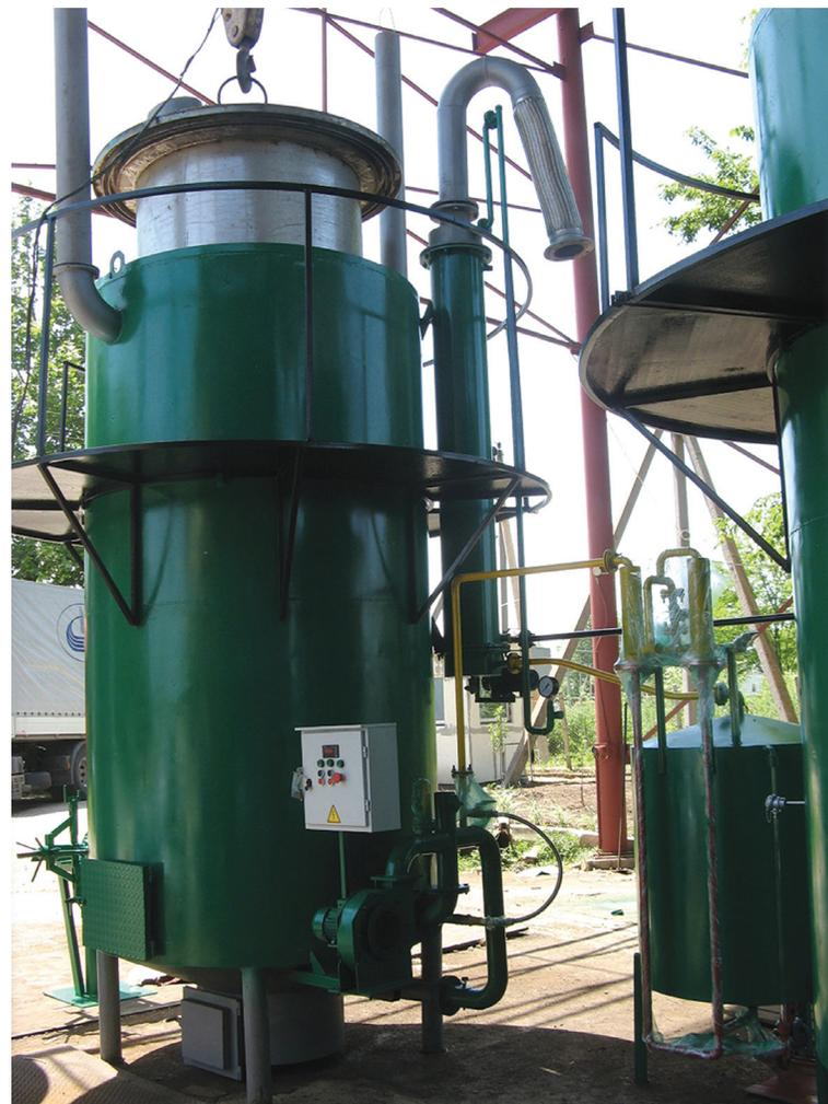
В процессе обезвреживания отходы разлагаются при недостатке кислорода и превращаются в газообразное состояние (биогаз), при этом выделяется тепло, которое используется для выработки электроэнергии для покрытия собственных нужд, а также тепловой энергии для систем отопления, вентиляции всего комплекса по переработке отходов.
